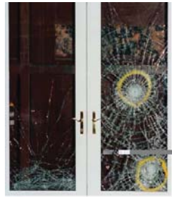
ภาพกระจกนิรภัยหลายชั้น กระจกเมื่อแตกจะไม่ร่วงหล่นจากกรอบบาน
