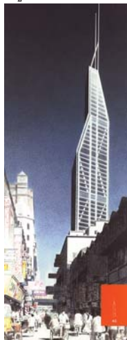
รูปที่ 14 อาคาร Wan Xiang International Plaza ในมหานครเซี่ยงไฮ้ ใช้เสาเอียงช่วยในการรับแรง
