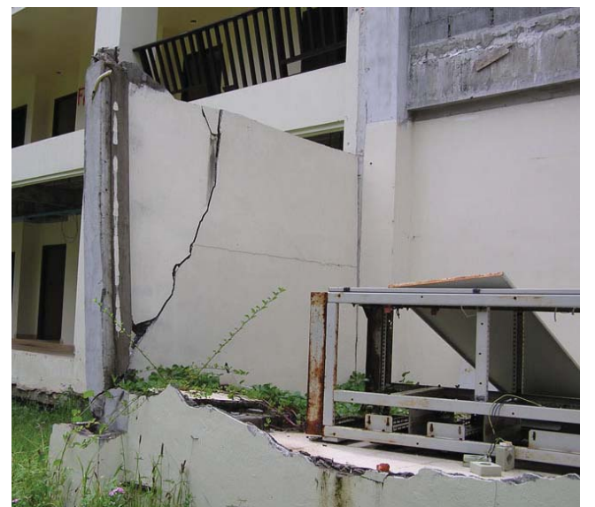
รูปที่ 3,4 การแตกร้าวของผนังก่ออิฐ จากการปะทะของคลื่น
