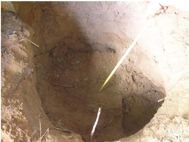
รูปที่ 10 จากการสำรวจพบว่า หลังฐานรากอยู่ลึกลงไปจากระดับผิวดินประมาณ 0.90 เมตร
