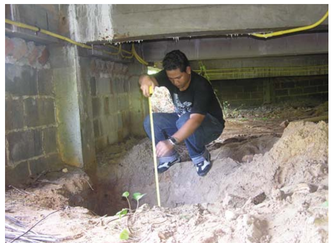
รูปที่ 9 การขุดสำรวจเพื่อวัดความลึกของฐานราก
