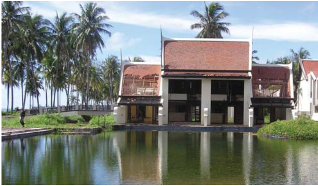
รูปที่ 5 อาคารที่ทดสอบน้ำหนักบรรทุก
